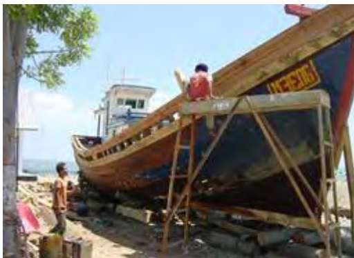
1.2 : Réparation d'un trawler
