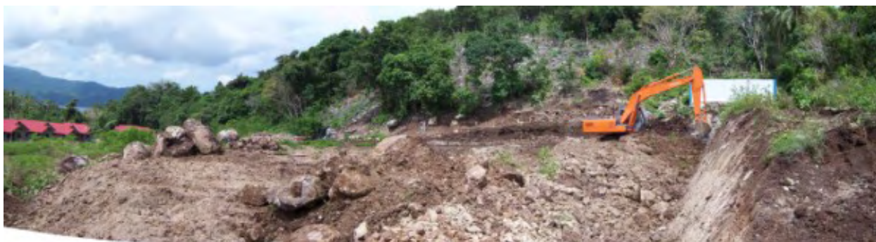
13 mars 2008 : Travaux de terrassement du site de la future école.
