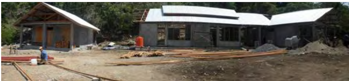
04 Juillet 2008 : Le bac acier de l'école est en train d'être posé.
