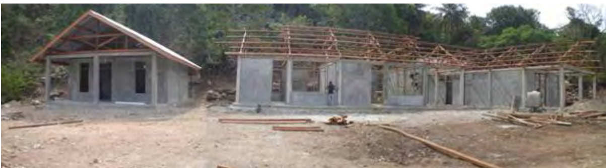
27 Juin 2008 : Le bac acier de la maison est posé. La charpente de l'école se termine.
