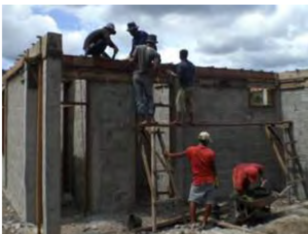
Fig 3.5 : Coulage de la poutre haute de l'école.
