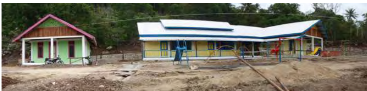
28 Août 2008 : La maison et l'école sont terminées. Fin des aménagements extérieurs en attente.
