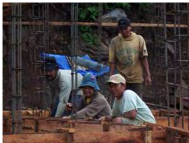
Fig 3.4 : Coffrage de la poutre basse de l'école.
