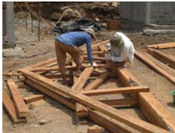
Fig 3.6 : Assemblage de la charpente
