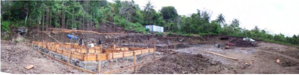
11 Avril 2008 : Coffrage de la poutre du bas de la maison.
