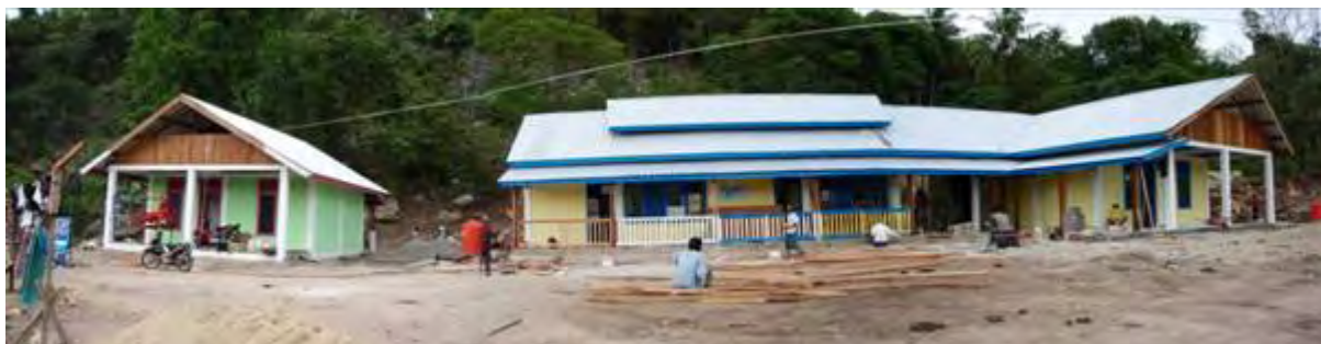
25 Juillet 2008 : Peinture, pose de portes et fenêtres...
