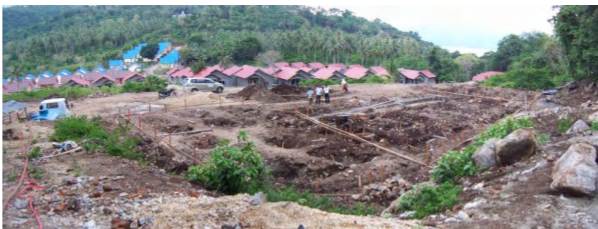
31 mars 2008 : Creusement des fondations
