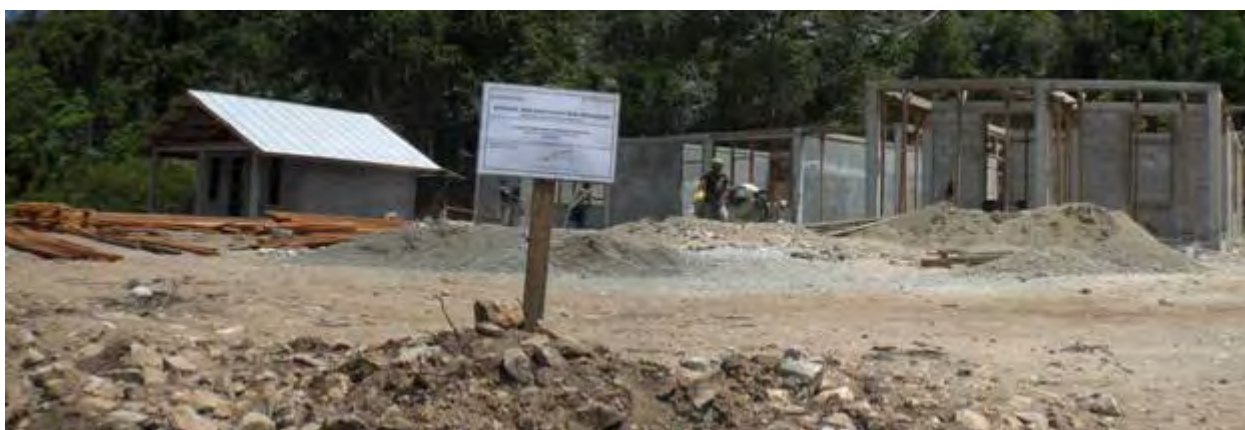
Fig 5.2 : Entrée du chantier d'Ujung Sekundo.
