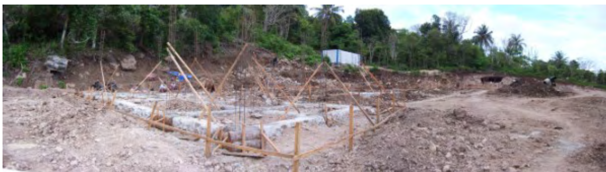
4 Avril 2008 : Positionnement des aciers des colonnes.
