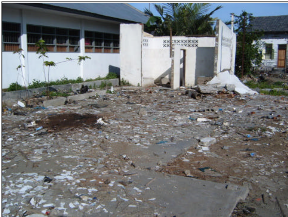
Ce qu'il reste des structures
