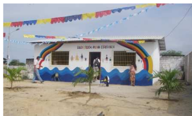
Type de local construit pour une ludothèque (ici en Equateur)
