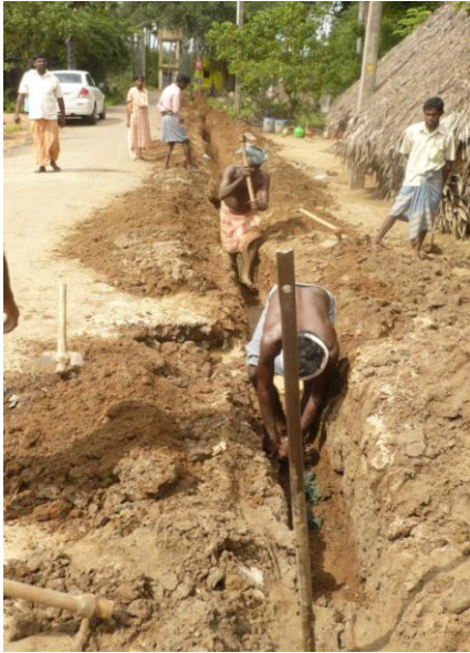
Pose des canalisations par les villageois à V.Kenipet
