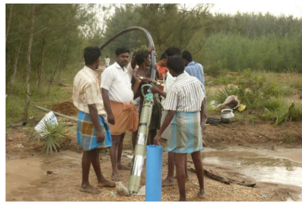
Installation de la pompe à V.Kenipet
