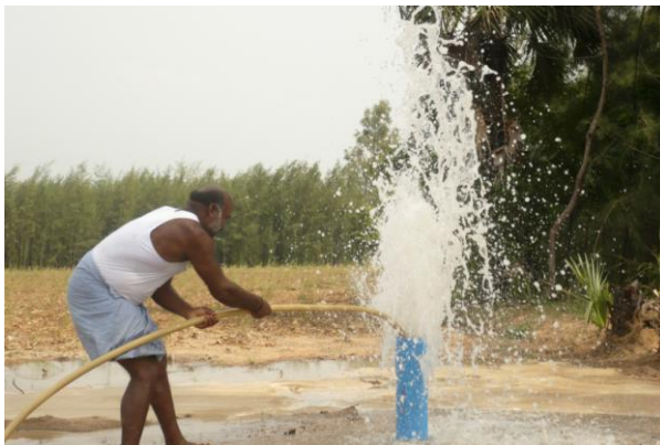
Compresseur nettoyant le forage à V.Kenipet
