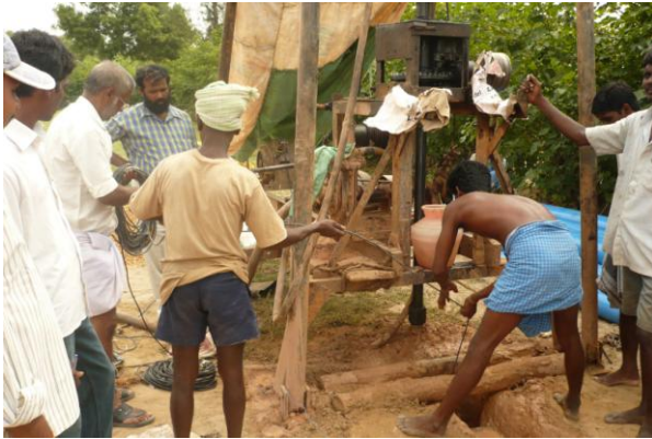
Réalisation du forage à Komidipattu
