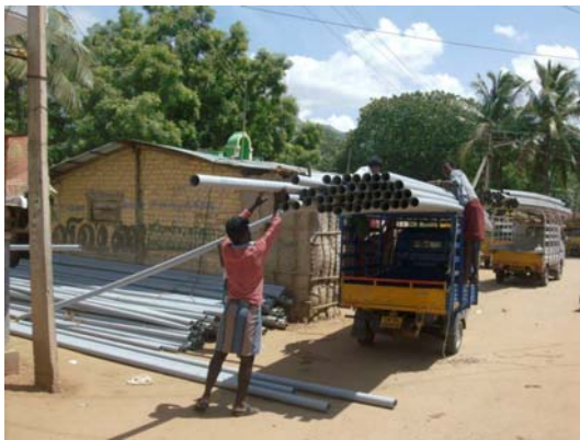
Photo 16 : Installation des canalisations
