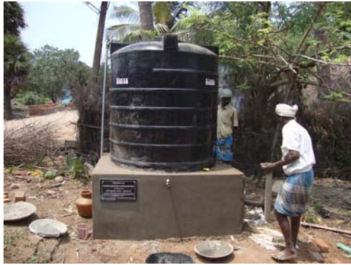
Photo 5 bis : Construction des réservoirs de stockage
